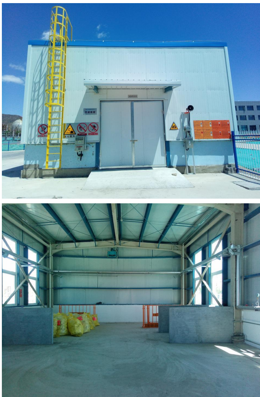
图 3.2-2 危险废物暂存间
